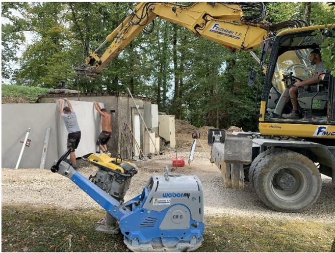
Profitant de l'occasion et des équipes engagées sur le terrain, nous avons décidé de revoir la protection extérieure du réservoir par l'installation de murs et ajout de terre afin que ce dernier soit quasiment enterré.
