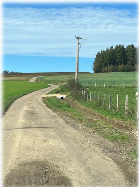
Fossé retravaillé et mis en place d'un tuyau pour l'accès à la pâture.
